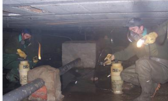
Cámara de aireación con encharcamientos de agua bajo edificio
