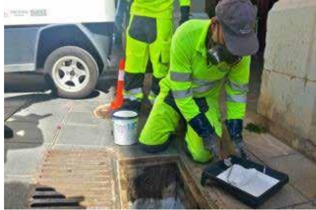
Técnico de LOKÍMICA aplicando la pintura en imbornales de un barrio especialmente conflictivo respecto a presencia de mosquitos de uno de nuestros clientes.
